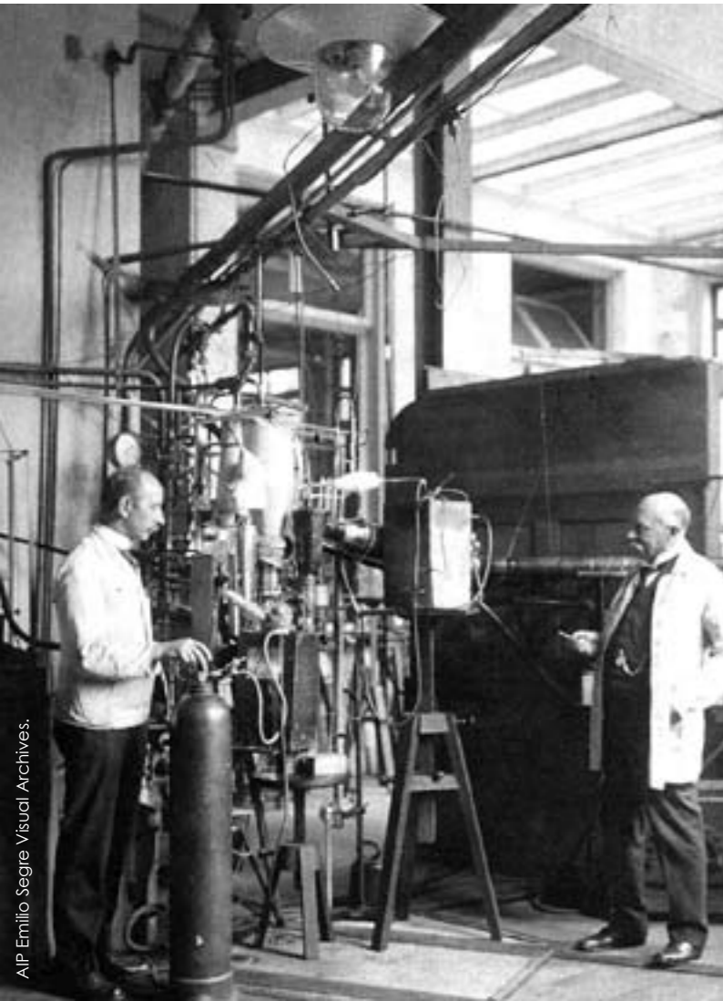
Kamerlingh Onnes y su ayudante Gerrit Flim frente al licuador de helio en el laboratorio de bajas temperaturas de Leiden (Holanda) y gráfica original de Onnes mostrando la transición superconductora del mercurio a 4.2 K.
