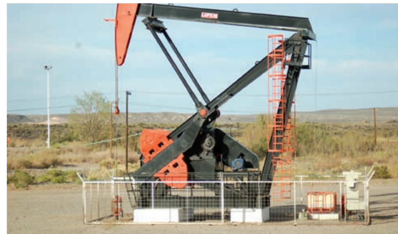
Una de las populares "cigüeñas" que extraen el petróleo en la zona de Puesto Hernández. Se trata de bombas para extraer el petróleo que se instalaban hasta hace unos años. Hoy en día siguen activas, pero las modernas son pequeñas y apenas se ven en el paisaje.
