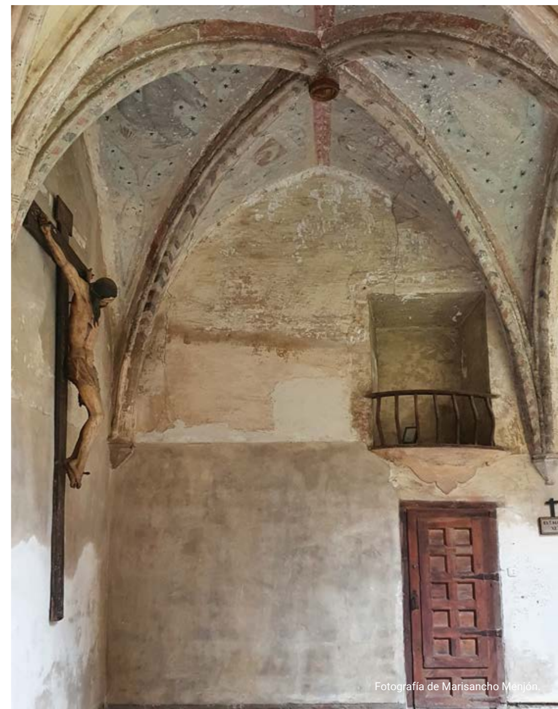
Imagen del Crucificado del claustro, con pinturas góticas en la bóveda.
