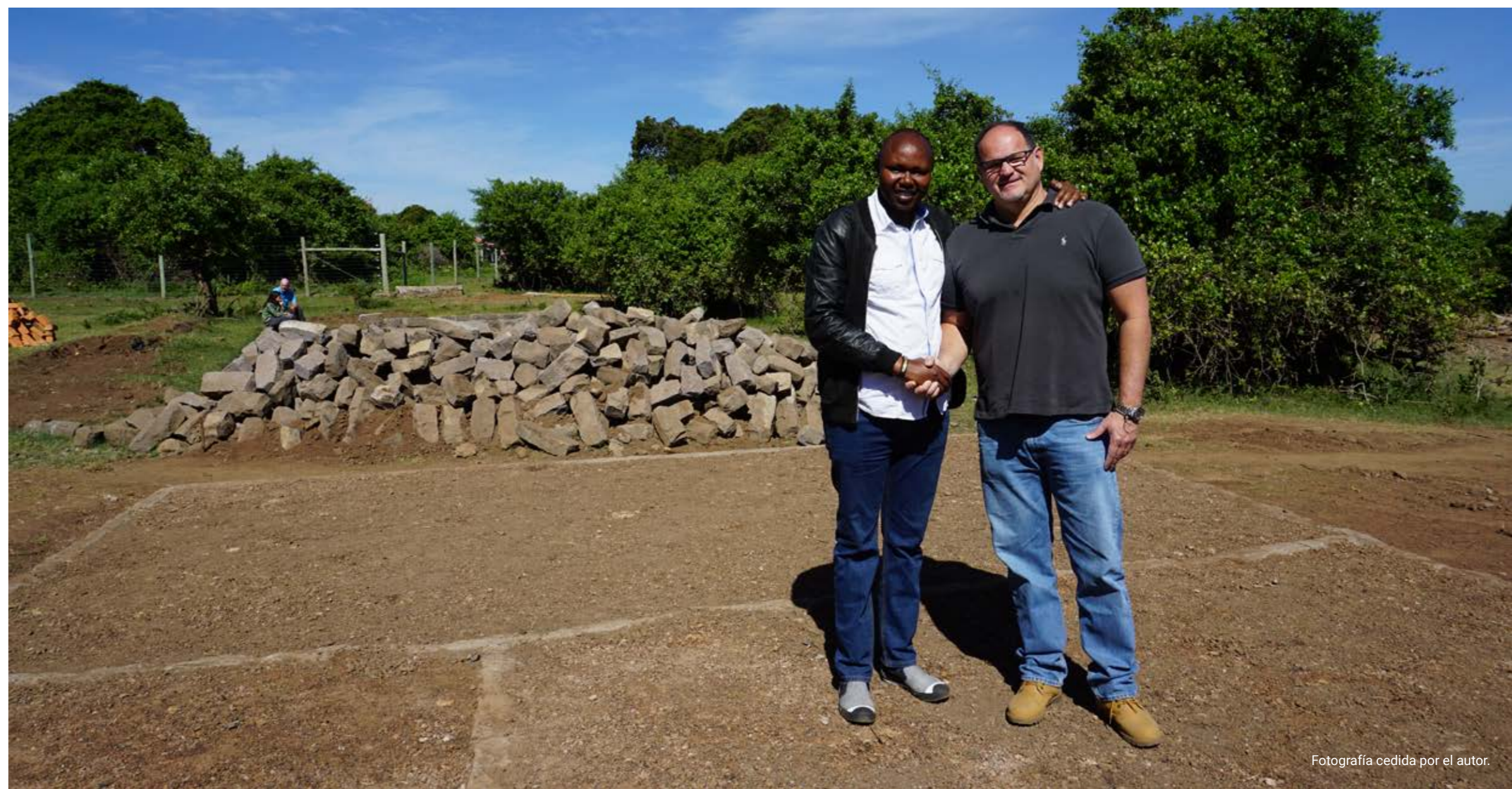
► Simon y los cimientos de la futura clínica.
