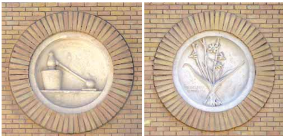
Medallones dedicados a la Química y a la Botánica (fachada oeste).
